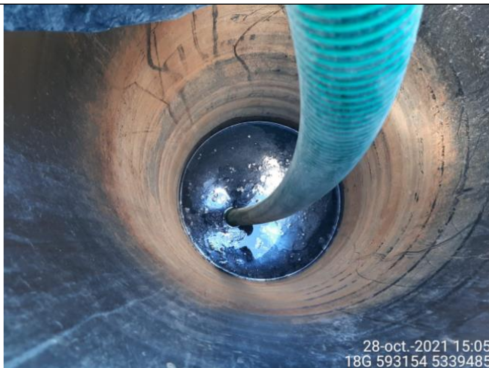
Fotografía N°9: Extracción de Lixiviados por parte de empresa Aconser. Tomada: Jueves 28 de Octubre del 2021
